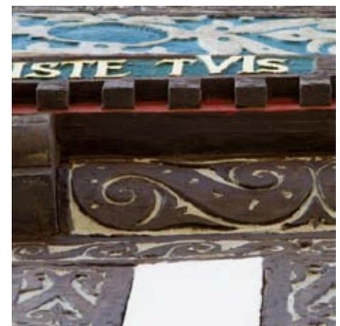
Abb. linke Seite: Was auf den ersten Blick wie Holzmaserung aussieht, ist dichtende Spachtelmasse, Feuchtigkeit dringt durch Risse in die Konstruktion ein, optimale Bedingungen für Pilzwachstum.
