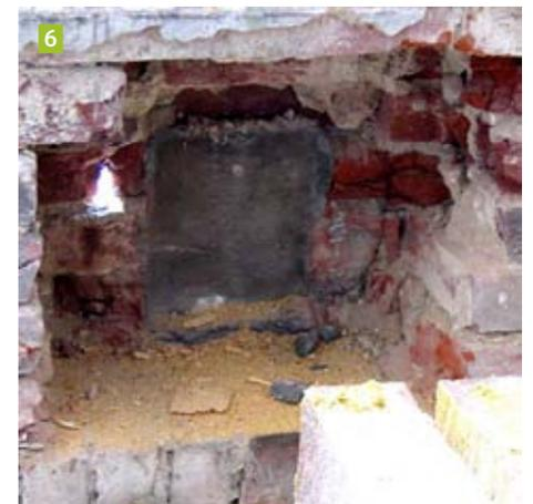
Abb. 6: Mauerwerksauflager nach Entfernung des defekten Balkenkopfes; die Stirnseite des Balkens hatte vollflächigen Kontakt zum Mauerwerk!
